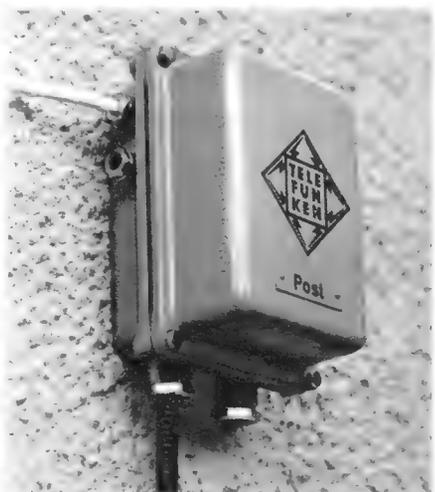
Bild 4. Grundstücksverstärker für fünf Teilnehmer. Von unten kommt die Stichleitung, nach links geht eine Teilnehmerleitung (zweiß) ab
